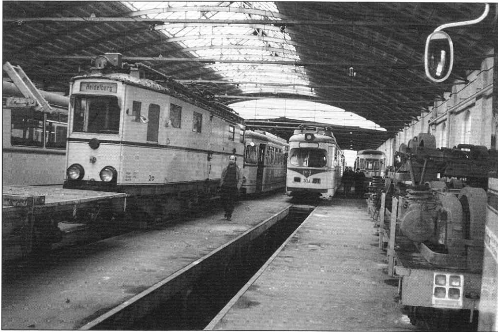
Heute nutzt die OEG die Wagenhalle in Viernheim noch für ihre Zwecke. Doch nach Abschluß der Arbeiten zur Verlängerung der Halle in Edingen möchte sich die OEG endgültig von der aufwendig zu unterhaltenden Viernheimer Halle trennen, 18. 3. 1995, Foto: Bernhard König
